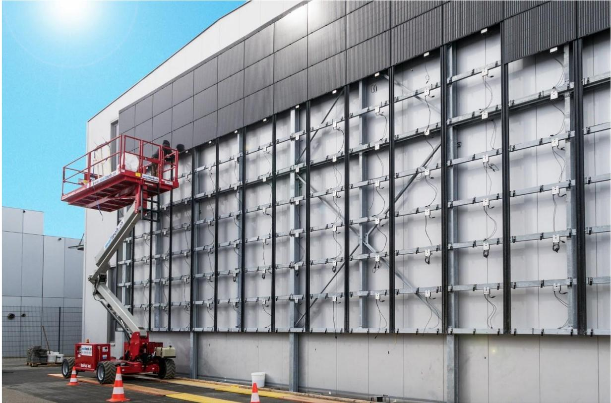
Abbildung 7: MegaSlate II Fassade mit Alu-Modullattung und Profilstahl-Unterkonstruktion
