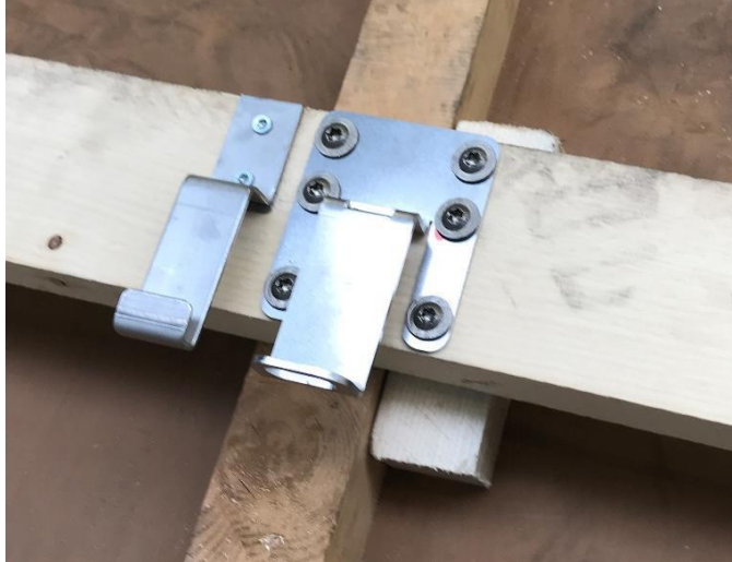
Abbildung 12 Angezogene Montageschrauben
