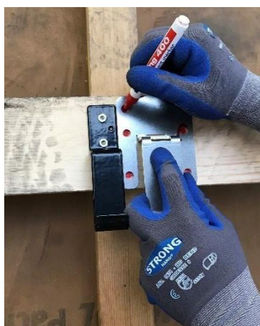
Abbildung 9 Markieren der Montagelöcher
