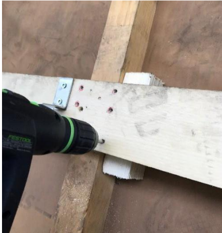
Abbildung 10 Vorbohren der Montagelöcher
