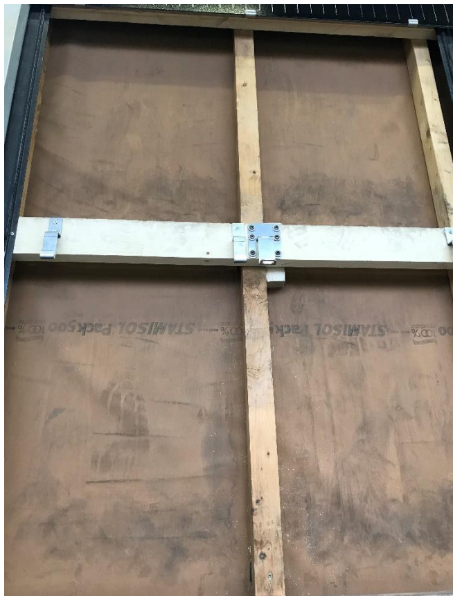
Abbildung 13 Übersichtsfoto der Montierten Anschlageneinrichtung
