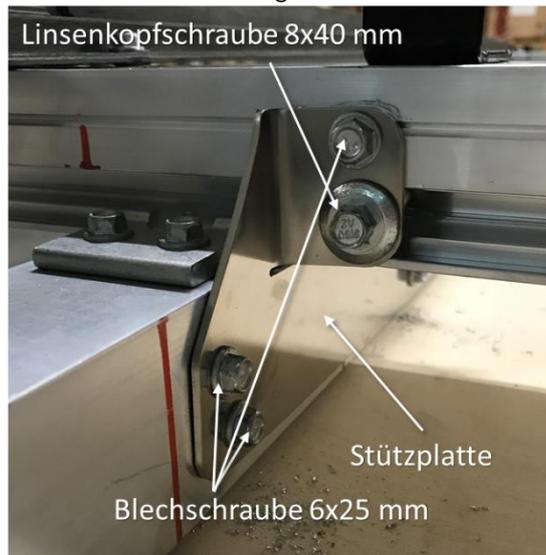
Abbildung 12 Montierte Stützplatte
