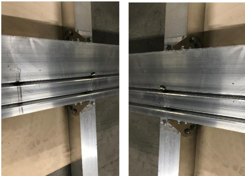
Abbildung 15 und 16 Fotodokumentation Details der Montagestelle
