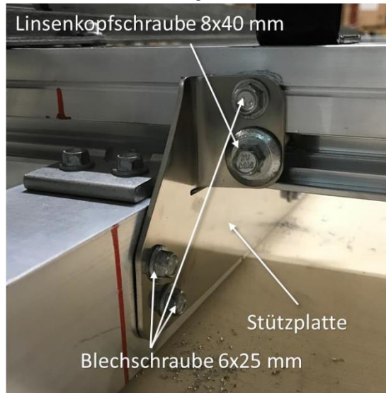
Abbildung 12 Montierte Stützplatte
